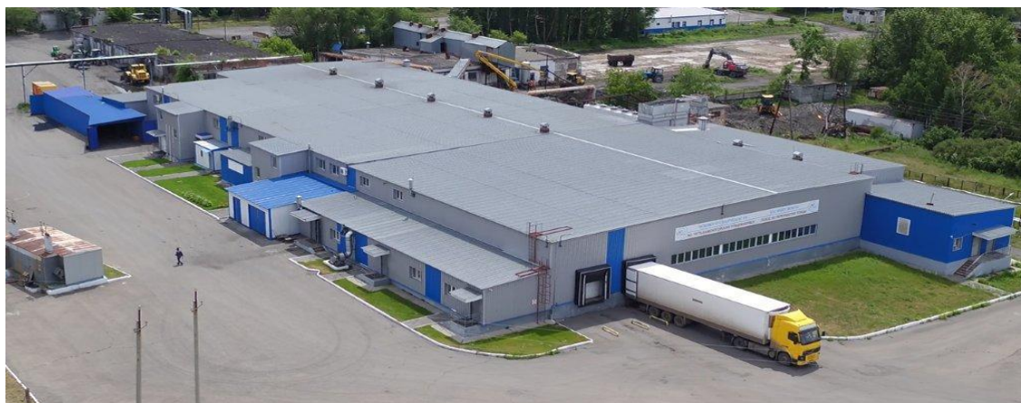
Рис. 7. Завод по переработке птицы
