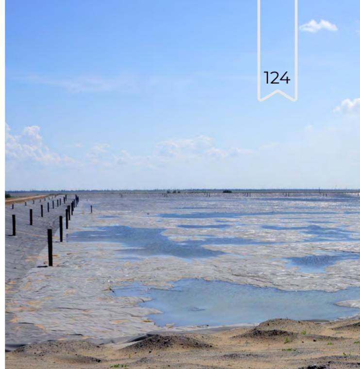
При строительстве новых карт золоотвалов применена новейшая технология противofильтрационного экрана в ложе золоотвала – **канадская полисинтетическая геомембрана.**
