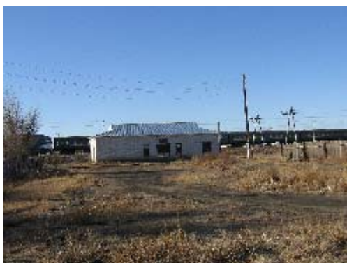
Фото 16. Ст. Шар. Подстанция
