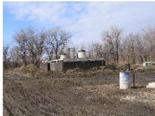
Фото 69. Ст. НУК. Емкость пожаротушения
