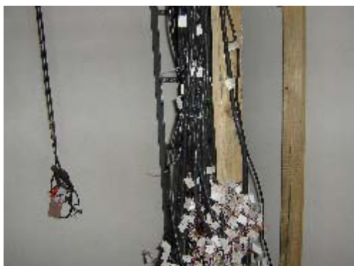
Фото 24. Раз. Сарыжал. Пост ЭЦ (вид изнутри)
