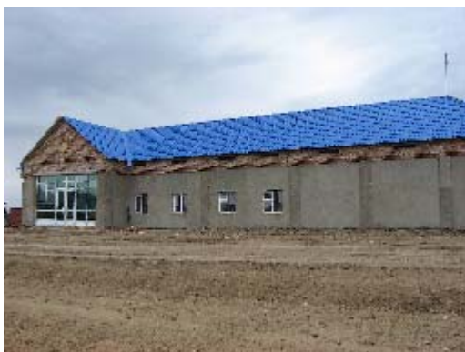
Фото 58. Ст. Завидное. Зал ожидания, пост ЭЦ
