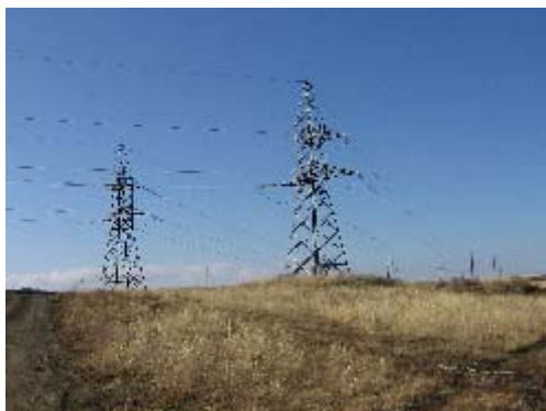
Фото 2. Опоры ЛЭП. ПК37
