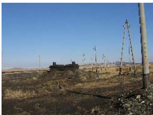
Фото 63. Раз. Молодежное. Резервуар пожаротушения
