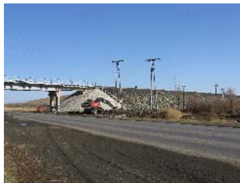
Фото 3. Опоры ЛЭП. ПК139
