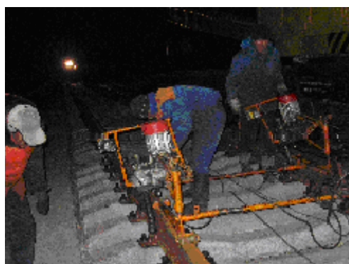
Фото 21. Ст. Шар. Процесс установки РШР
