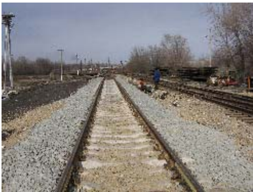
Фото 74. Ст. НУК. Железнодорожные пути
