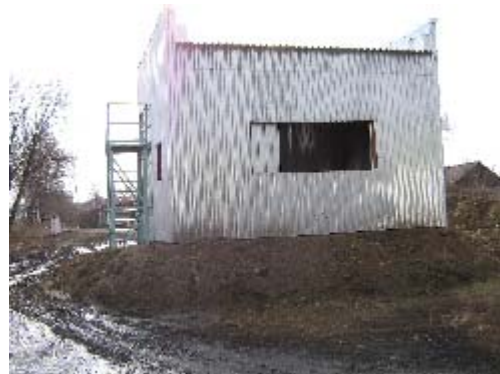
Фото 67. Ст. НУК. Компрессорная
