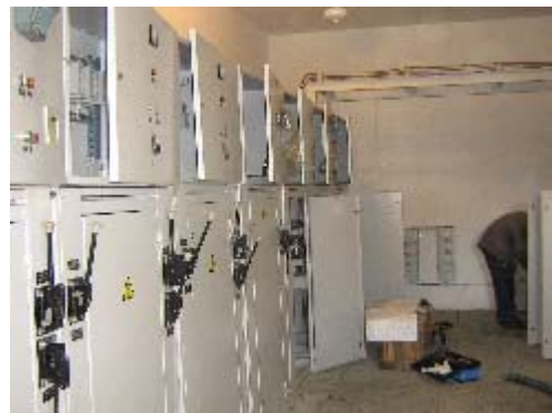
Фото 71. Ст. НУК. Подстанция (вид изнутри 1)
