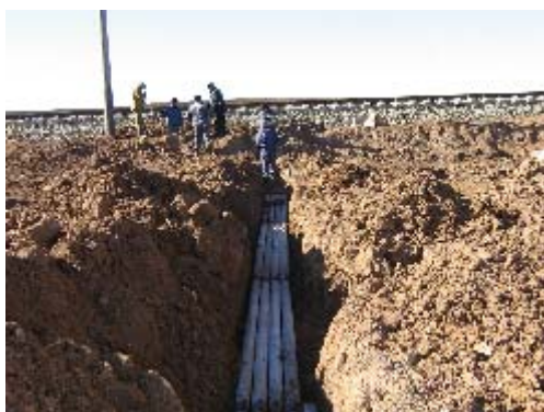
Фото 26. Раз. Сарыжал. Прокладка кабелей
