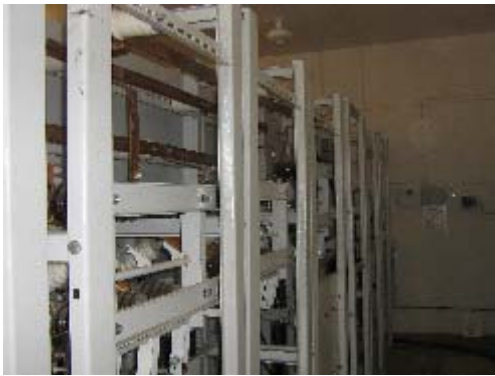
Фото 72. Ст. НУК. Подстанция (вид изнутри 2)
