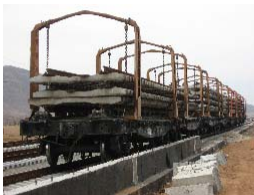
Фото 60. Ст. Завидное. Путьевой укладчик
