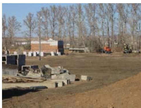
Фото 43. Ст. Шалабай. Насосная станция
