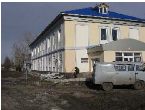
Фото 70. Ст. НУК. Пост ЭЦ
