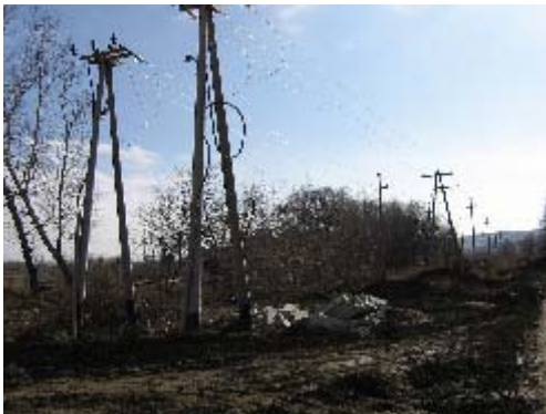
Фото 68. Ст. НУК. ЛЭП
