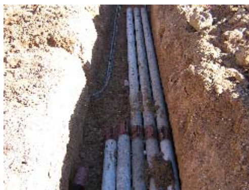
Фото 27. Раз. Сарыжал. Прокладка кабелей
