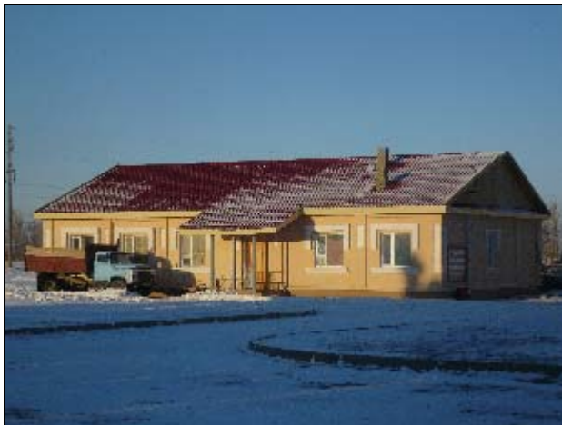
Фото 23. Станция Шалабай. Жилой дом (1)
