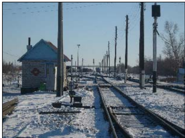
Фото 2. Станция Шар. Будка чистильщиков стрелок
