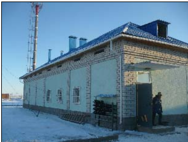
Фото 21. Станция Шалабай. Пост ЭЦ
