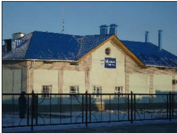
Фото 18. Станция Шалабай. Пост ЭЦ
