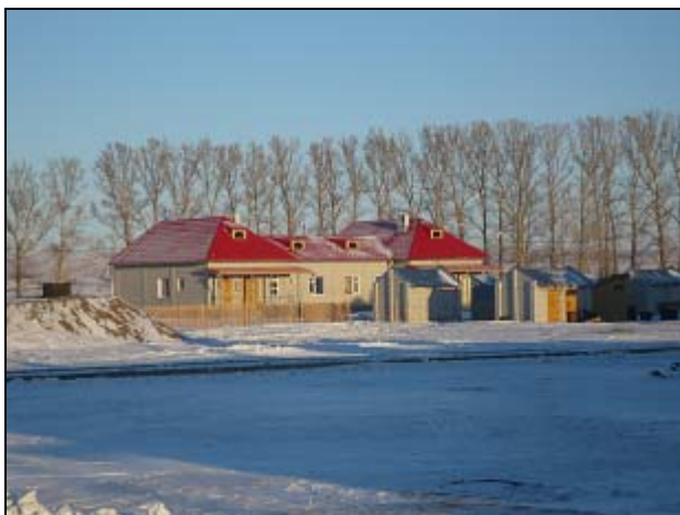
Фото 25. Станция Шалабай. Жилой дом (3)
