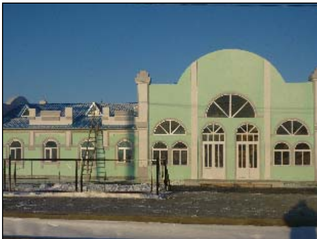
Фото 19. Станция Шалабай. Зал ожидания
