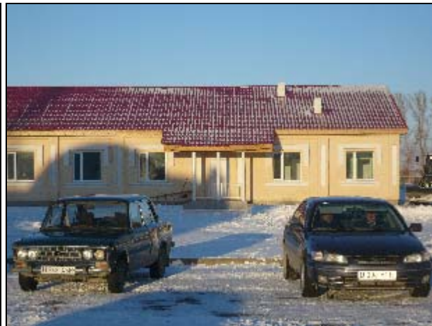
Фото 24. Станция Шалабай. Жилой дом (2)
