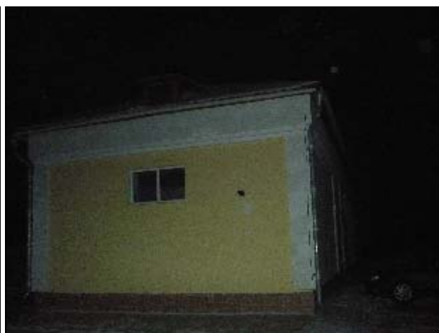
Фото 38. Станция НУК. Пост ЭЦ
