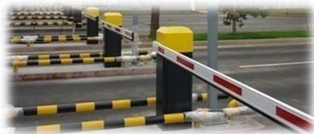
Автоматическая система парковки «Modpark», которая состоит из 4 въездных и 7 выездных групп, 6 автоматических кассовых терминалов, программного обеспечения, подсистемы видеоидентификации и распознавания государственных номеров автомобилей (VISPA) и обзорного видеонаблюдения «Designa-Asytec».
